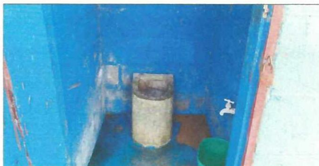
Foto 6: Se cambiará la tasa del sanitario por una tasa nueva y lavable
