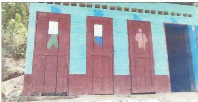
Foto 5: Se cambiará las puertas de madera gastadas y deterioradas parcial o total por puertas nuevas de metal para los sanitarios
